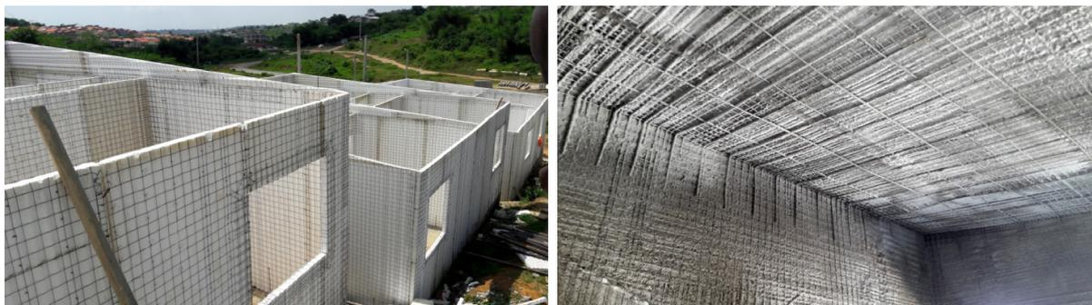
*Illustrations : A gauche, réservations préparées pour accueillir les câbles électriques ; à droite, rendu final du gros œuvre, similaire à des voiles béton*
